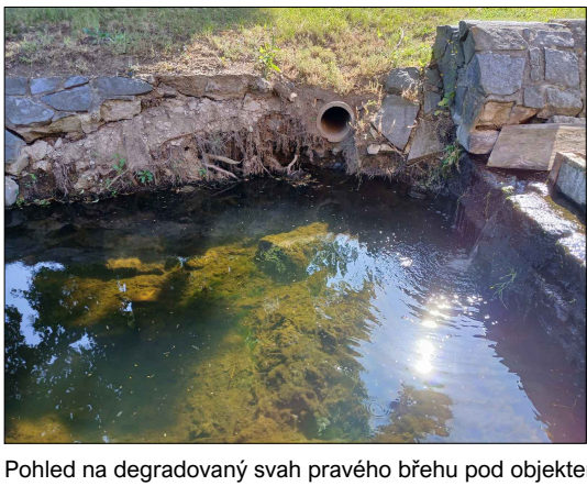
Pohled na degradovaný svah pravého břehu pod objektem.
