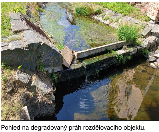
Pohled na degradovaný práh rozdělovacího objektu.
