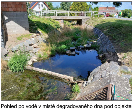
Pohled po vodě v místě degradovaného dna pod objektem.
